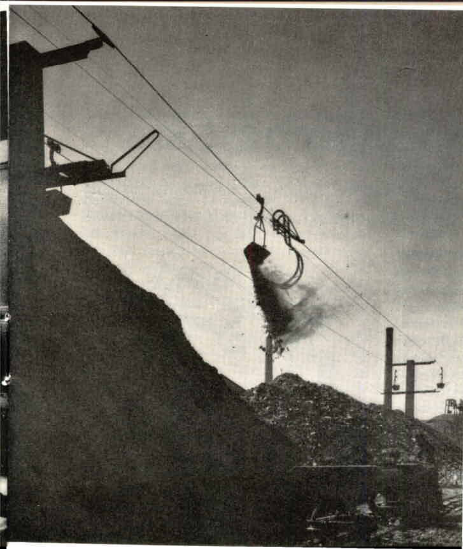
Fig. 14. »I Skromberga transporteras de krossade lerprodukterna liksom kolen med hänglinbana till lagerplatserna, där korgarna tippas automatiskt.»
