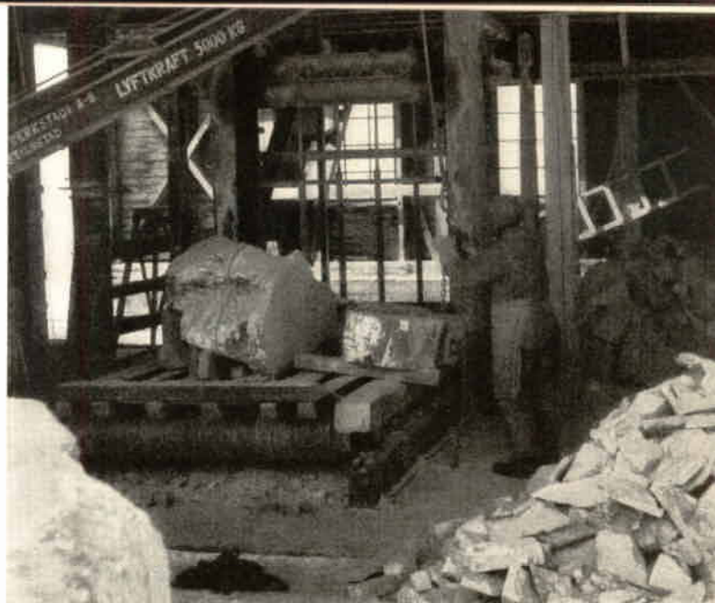
I ramsågen klyvas täljstensbumlingarna lika lätt, som man skär smör med kniv.
