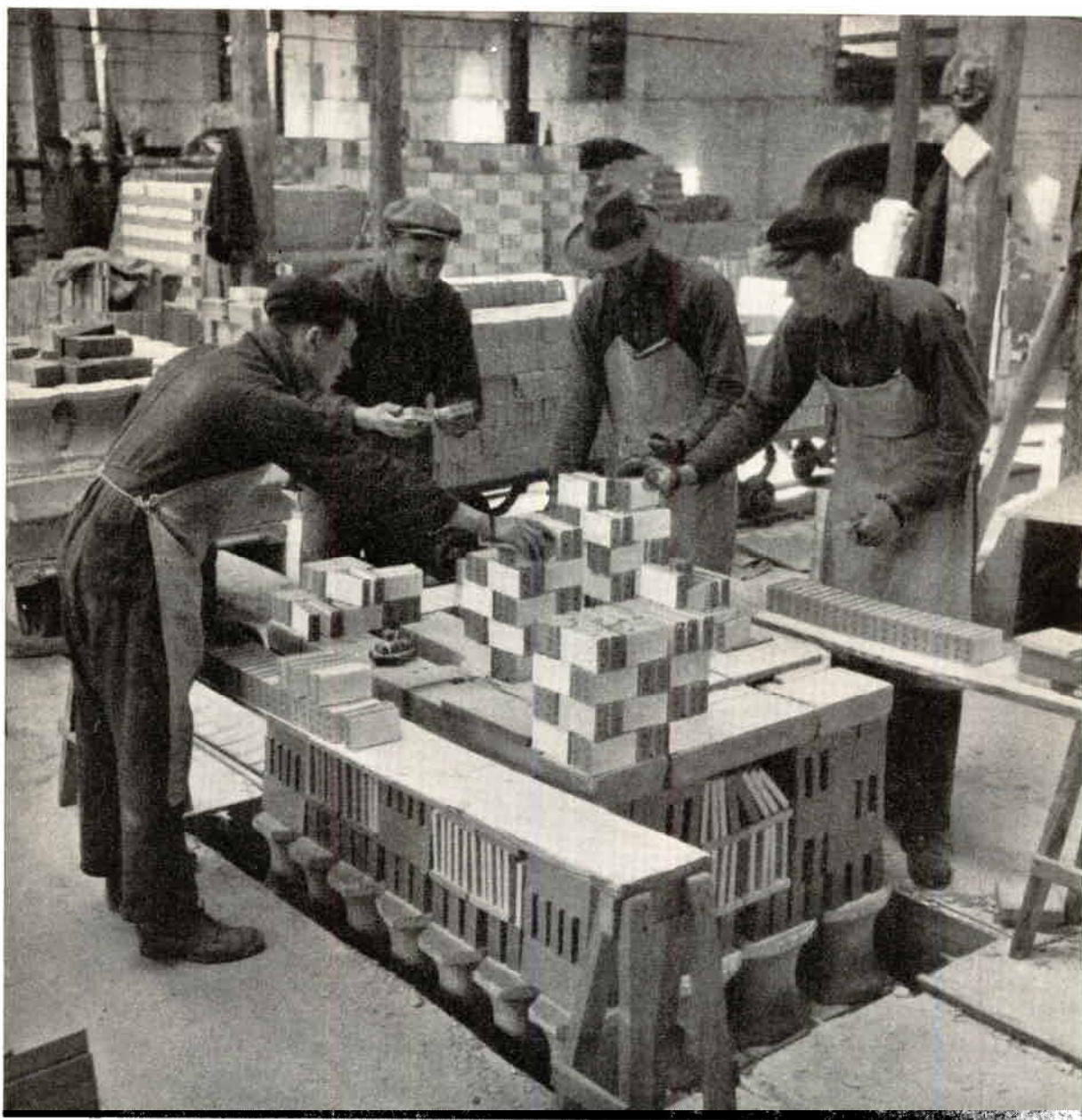
Klinker sorteras från brännvagnen. Allteftersom arbetet fortskrider höjes vagnen, så att man alltid arbetar på bekväm höjd.
