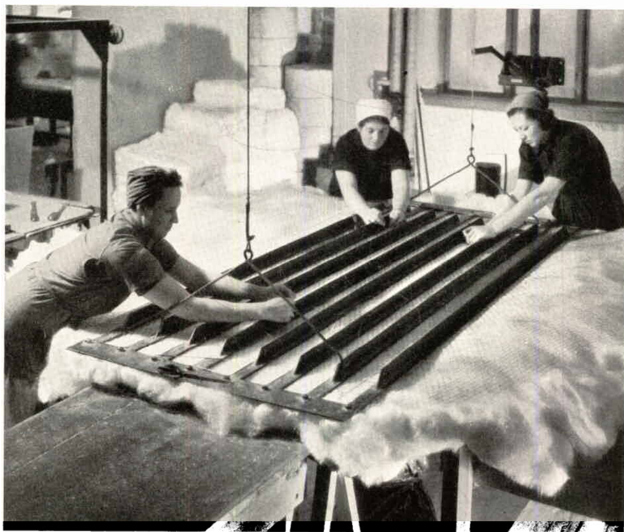
»Flickorna i Billesholm» tillverka Glasullit-mattor efter mått.
